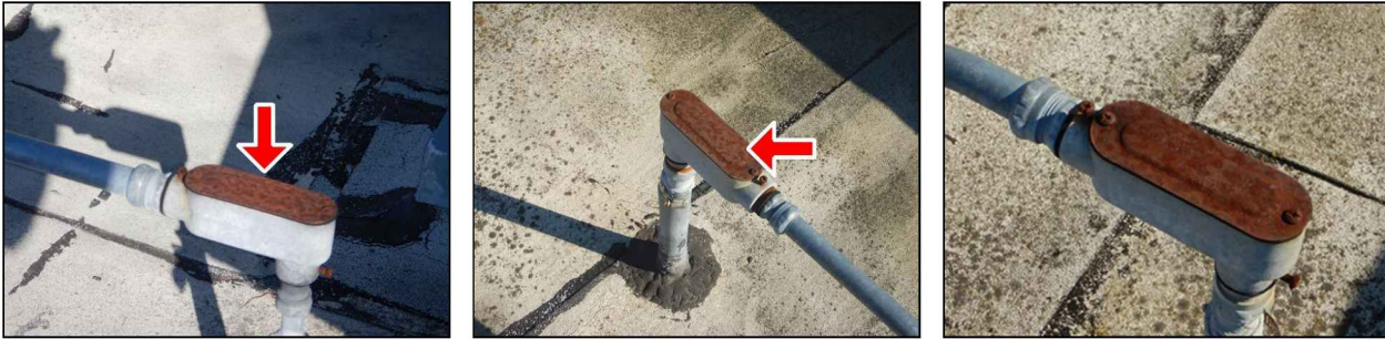
Corroded conduit
